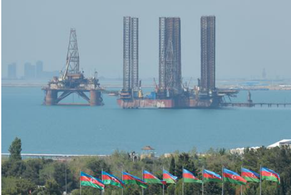
Plataforma de gas en el Mar Caspio en la costa de Baku, Azerbaiyán. (Artur Widak/NurPhoto via Getty Images)
